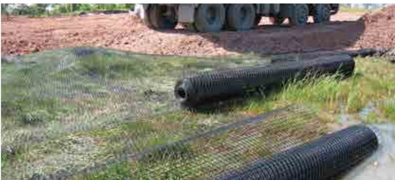
Gia cố nền đất phục vụ xây dựng bãi đỗ xe tại Lanarkshire
