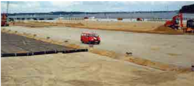
Lưới địa kỹ thuật Tensar được sử dụng để gia cố nền bến cảng tại Latvia
