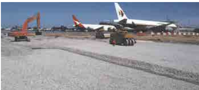
Đường taxiway mới tại sân bay Adelaide (Australia)
