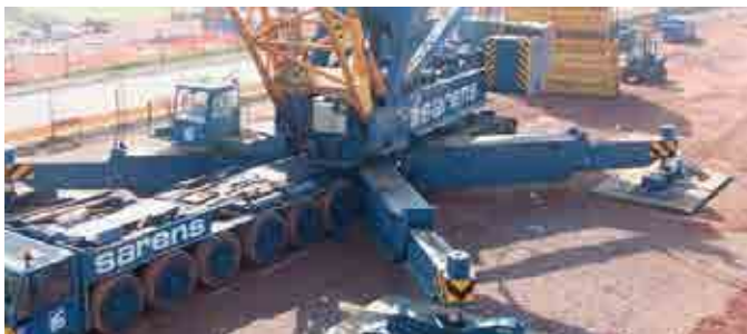
Cần cẩu hạng nặng hoạt động trên nền móng được gia cố với lưới địa kỹ thuật Tensar TriAx
