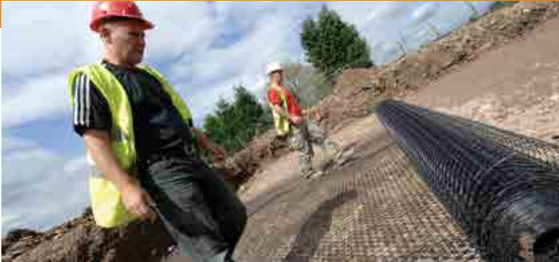
Lắp đặt lưới địa kỹ thuật TriAx, Stoke
