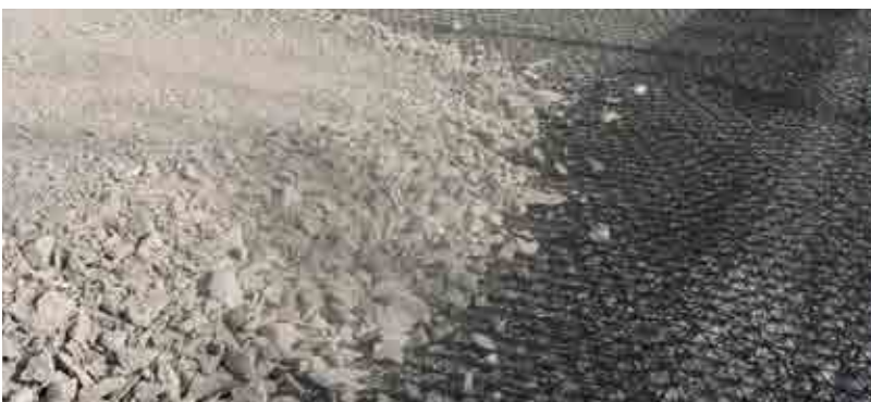
Cải thiện và gia cố đường A66 tại Melsonby
